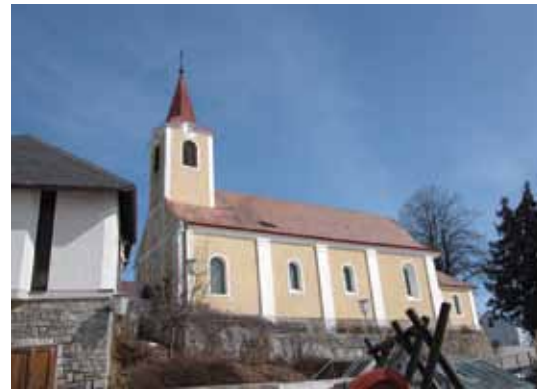
Die Gemeinde leistet u. a. einen Beitrag zur Sanierung der Fassade der Pfarrkirche Jagenbach.
