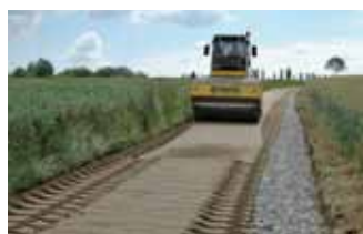
Herstellung des Unterbaues
