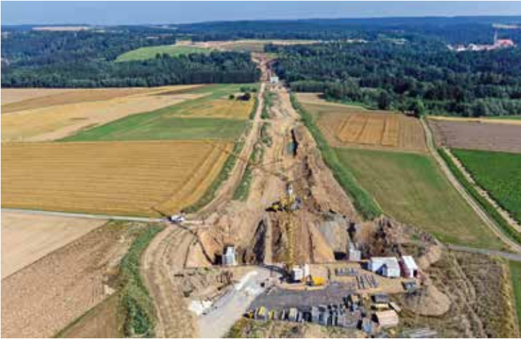
Erdbau- und Brückenbauarbeiten auf der B 38 Haupttrasse in Blickrichtung von „Anschlussstelle Zwettl Ost“ nach „Talübergang über den Kamp“ (Himmelsrichtung Nordwest) und Stift Zwettl rechts im Hintergrund
