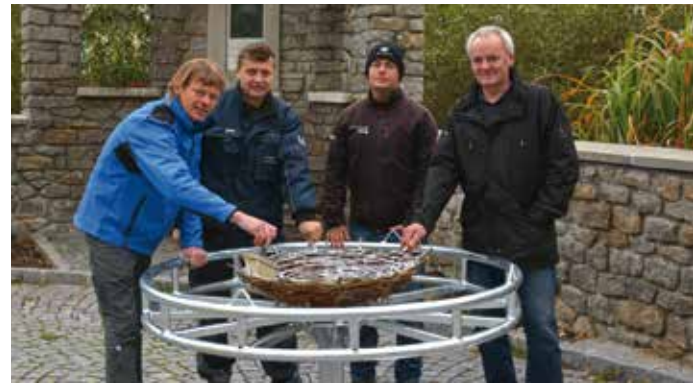
Bauhofmitarbeiter Christian Vogl und Walter Löffler, Mag. Lukas Strobl und Vizebürgermeister DI Johannes Prinz (v. l.) mit dem „Rohbau“ für das neue Zwettler Storchennest.
