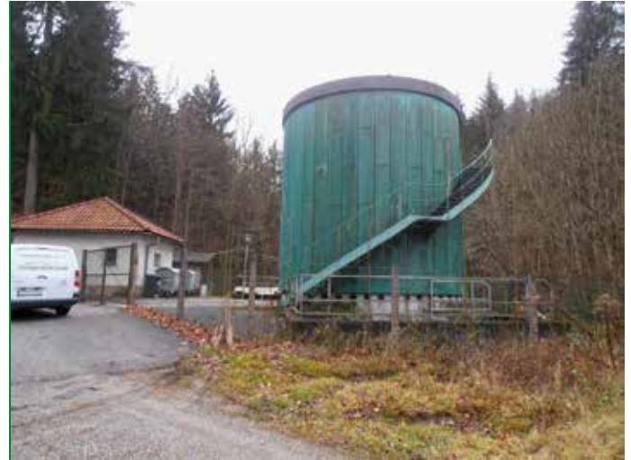
Die derzeitige Abwasserreinigungsanlage ist veraltet.
