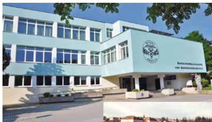
Das moderne Schulgebäude heute (Foto oben)
