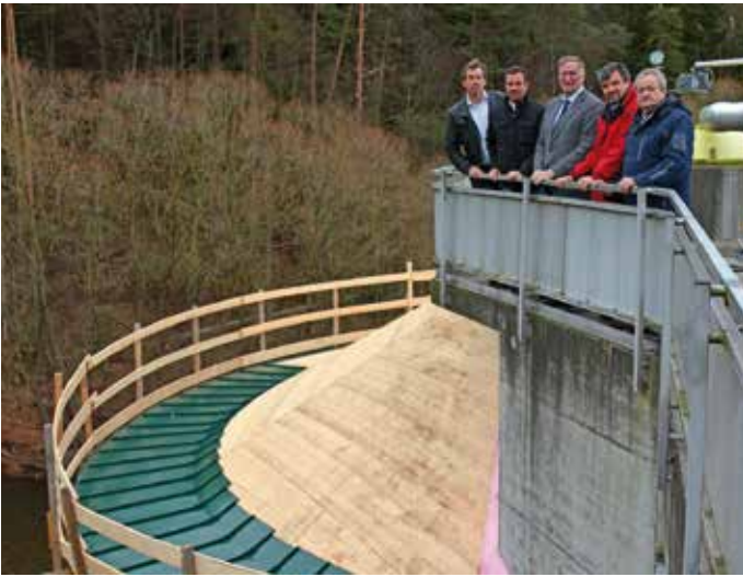
Ing. Michael Musil, Ing. Rainer Lugauer, Bgm. Herbert Prinz, StR Ing. Ewald Gärber und Norbert Bernhart (v. l.) am Dach des renovierten Faulturms.
