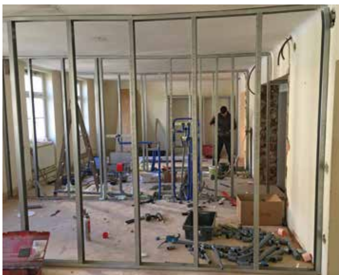
Raumtrennwände in Leichtbauweise werden im Erdgeschoß hergestellt. (Aufnahmedatum: 30. Oktober 2018)
