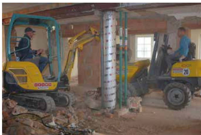
Abbrucharbeiten im Erdgeschoß, wo das neue Standesamt mit Trauungsraum entsteht (Aufnahmedatum: 16. Oktober 2018)
