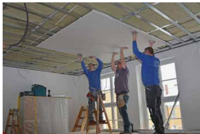
Im 1. Obergeschoß werden Akustikdecken montiert. (Aufnahmedatum: 20. November 2018)
