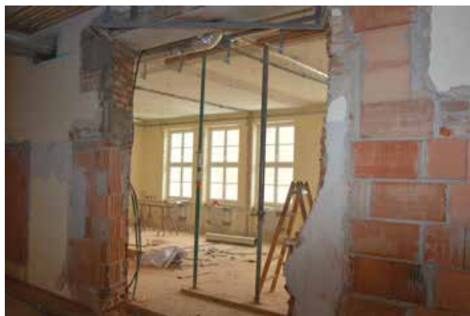
Mauerdurchbruch im Eingangsbereich zur Kassa (1. OG) (Aufnahmedatum: 20. November 2018)
