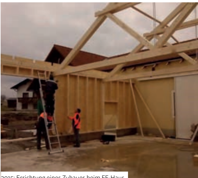
2015: Errichtung eines Zubaues beim FF-Haus
