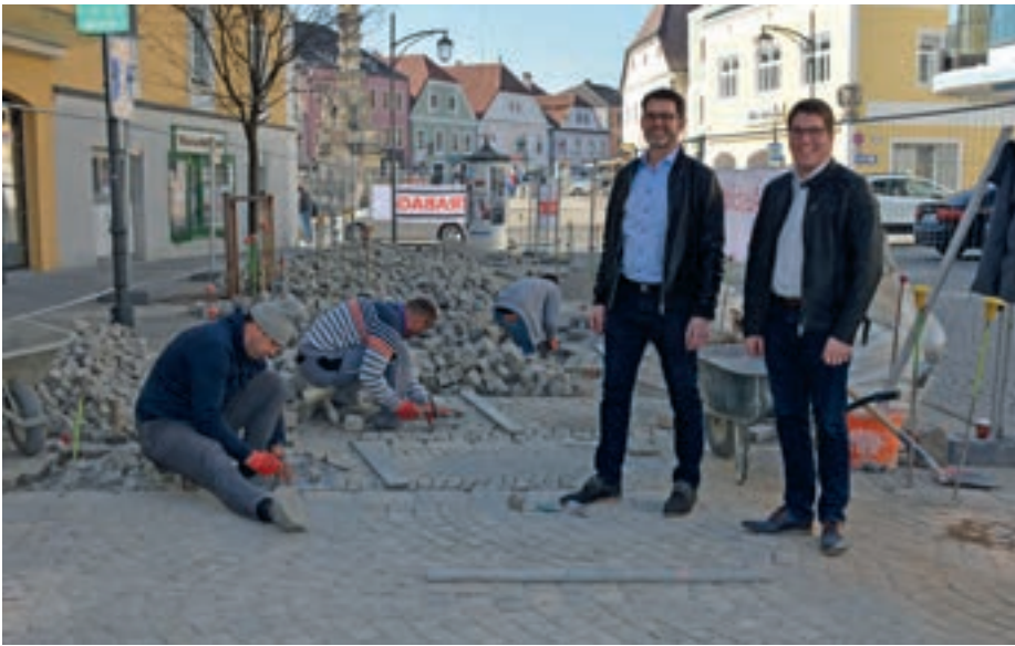
Am 24. März wurde bereits tüchtig gepflastert. Davon überzeugten sich die Projektleiter des Stadtamtes Ing. Hannes Meisner (2. v. r.) und Ing. Michael Tüchler (r.).
