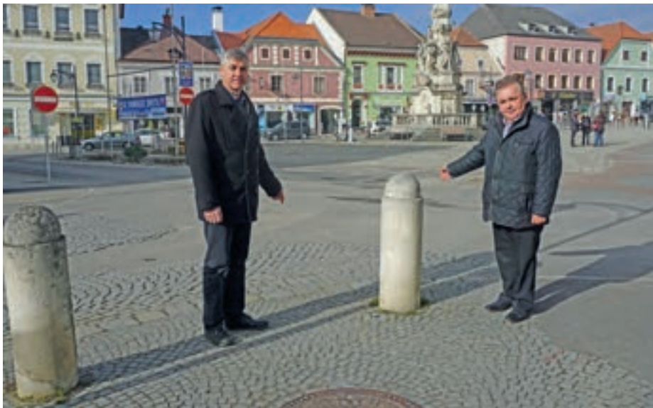
Stadtrat Gerald Knödlstorfer und Bürgermeister LAbg. Franz Mold vor einer der Sandsteinsäulen, die im Zuge der Bauarbeiten durch Poller aus Edelstahl ersetzt werden.
