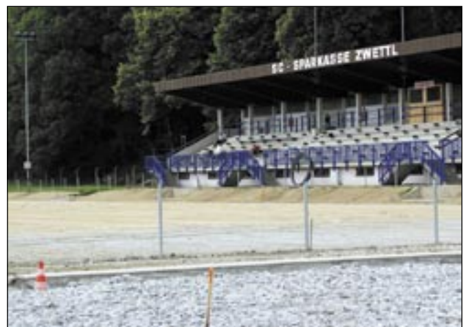
Die Sanierung der Sportanlage im Zwettlital schreitet zügig voran.
