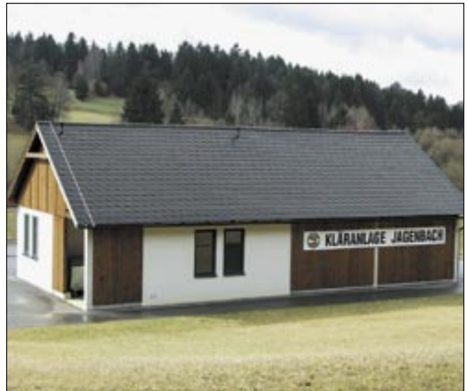
Beispiel für eine öffentliche Abwasserreinigungsanlage: Kläranlage Jagenbach
