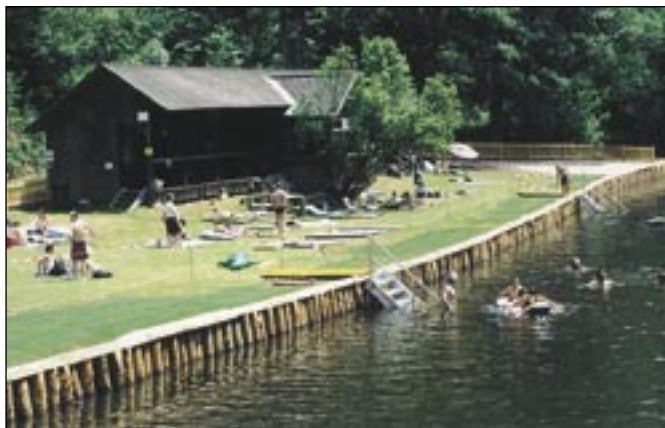
Ansicht des sanierten Sonnenbades im Kampthal
