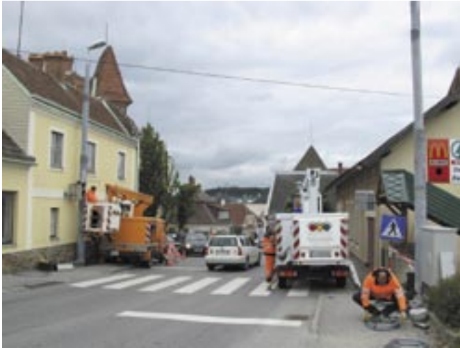
Montage der Druckknopf-Ampel beim Schutzweg Weitraer Straße, aufgenommen am 8. Juni 2005
