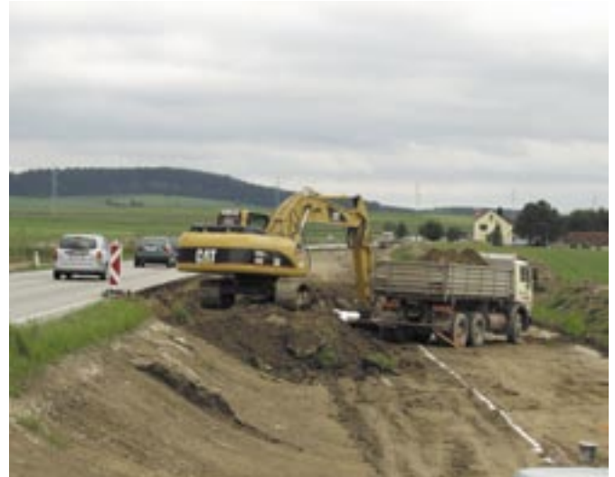
B38: drei Fahrstreifen auf der gesamten Länge des Bauloses
