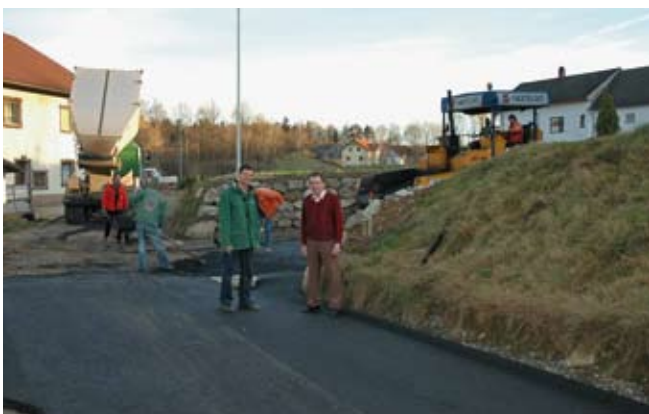
Asphaltierungsarbeiten in Niederglobnitz
