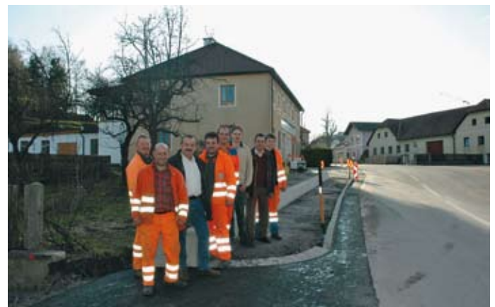
In Marbach am Walde wurde heuer mit der Errichtung eines neuen Gehsteiges begonnen.
