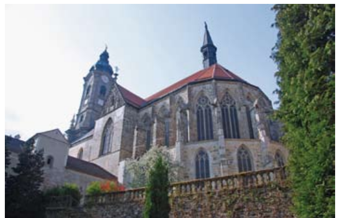
Innensanierung der Stiftskirche wird unterstützt.
