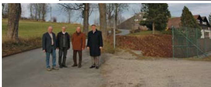
Auch die Zufahrtsstraße zur Tennisanlage bei der Zwettler Propstei wurde saniert und neu asphaltiert.
