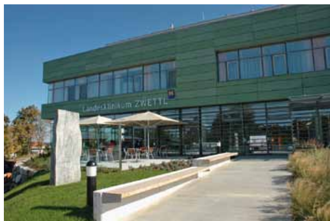
Dank umfangreicher Zu- und Umbaumaßnahmen ist das Landesklinikum Zwettl auch von der Gebäudekapazität her „auf neuestem Stand“.
