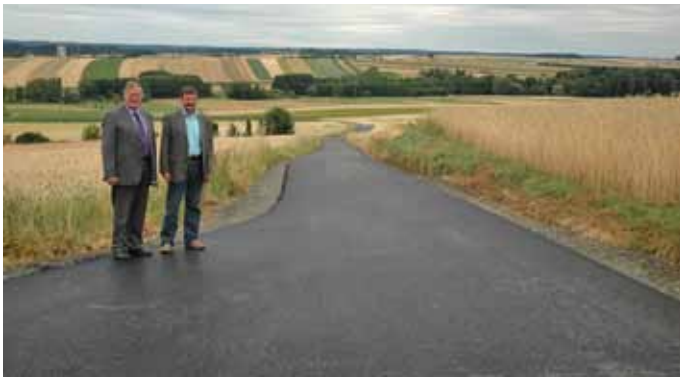
Lokalausweis beim Gemeindeweg Koblhof: Bürgermeister Herbert Prinz und Stadtrat Erwin Engelmayr überzeugten sich von den durchgeführten Asphaltierungsmaßnahmen
