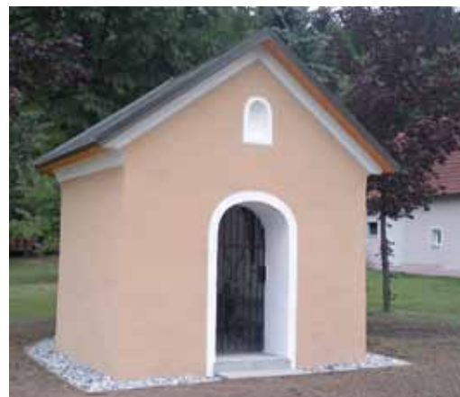
Das Marterl in Oberwaltenreith erstrahlt nach der Sanierung in neuem Glanz.
