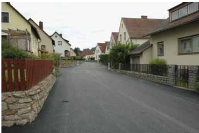
Die Siedlungsstraßen wurden komplett neu asphaltiert, hier als Beispiel der Blick in die Haydnstraße.
