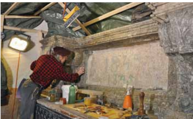
Beispielfoto für die Restaurierungsmaßnahmen: Der Restaurator Kazimierz Lipinski führte u. a. im Bereich des Apostelaltars Stuckmarmor-Restaurierungen durch.
