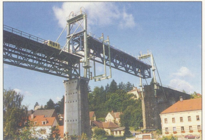
Eisenbahnbrücke: Hunderte Schaulustige beobachteten Arbeit
