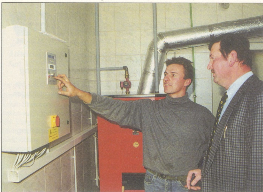
Umweltgemeinderat Erwin Engelmayr (re): „Innovative Heizanlagen helfen Energieverbrauch senken und werden von der Gemeinde gefördert“
