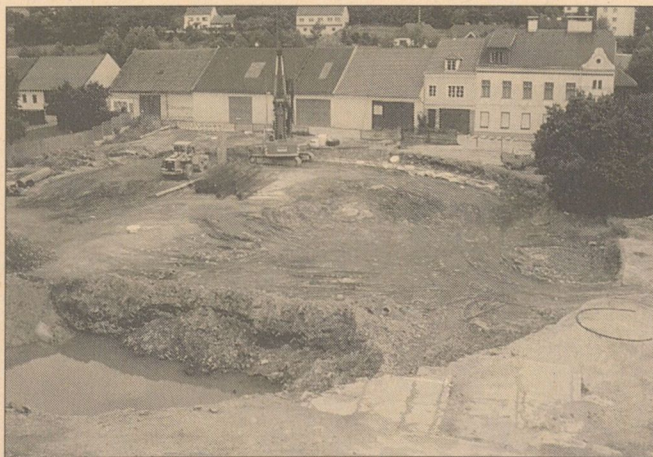
1996 wurde mit dem Bau der Parkgarage begonnen; Fertigstellung voraussichtlich Juni 1997
