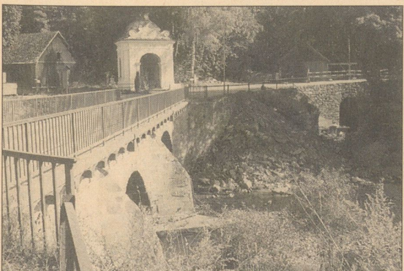
Stift Zwettl: Restaurierung der Kampbrücke wurde notwendig
