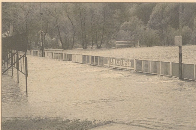
Nach dem Hochwasser im Mai 1996 mußte der Sportplatz saniert werden.
