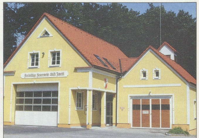
Entspricht den Anforderungen: das neue Feuerwehrhaus
