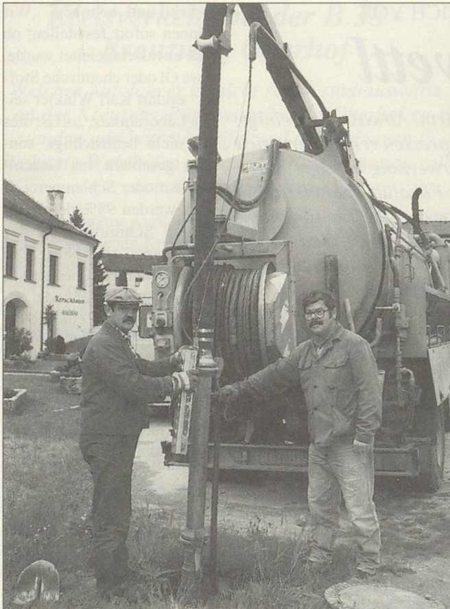
Der Kanalspülwagen: Josef Hahn und Karl Burger sind für den Kanalspülwagen zuständig. Sie reinigen und spülen regelmäßig das ca. 50 km lange Kanalnetz. „Einmal wöchentlich reinigen wir auch die sechs Dücker, die unter dem Flußbett der Zwettl und des Kamps verlaufen,“ erklärt Josef Hahn, „Sand und sonstige Ablagerungen können hier sehr leicht den Kanal verstopfen.“ „Zusätzlich dazu rücken wir zu ca. 200 Einsätzen im Jahr aus,“ so Karl Burger, der mit seinem Arbeitskollegen schon so manches Mal rettender Engel in der Not war.
