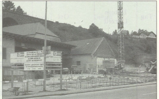
Derzeit noch Baustelle: Altstoffsammelzentrum
