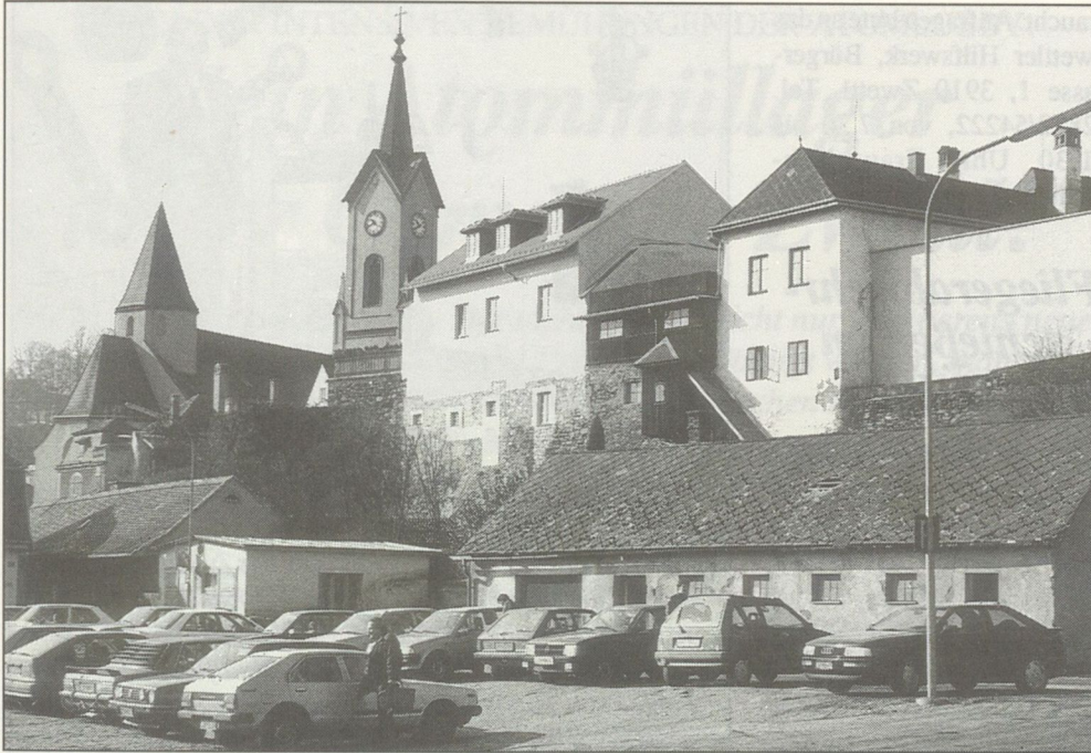
Parkdeck muß zur Stadtmauer passen: Der beste Architektenvorschlag wird verwirklicht!
