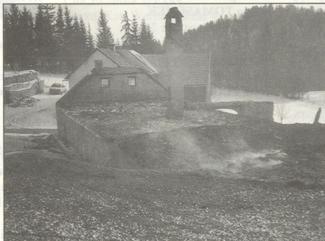
Der letzte große Brandfall: Das Einzelgehöft brannte bis auf die Grundmauern und den Rauchfang nieder
