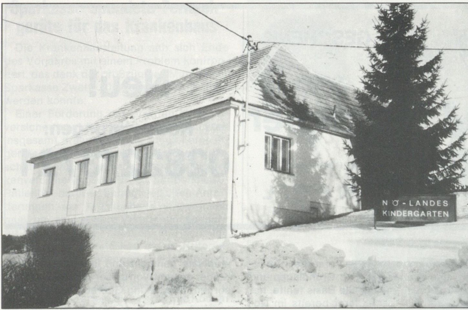
Das Dach des Kindergartens Marbach am Walde muß erneuert werden.
