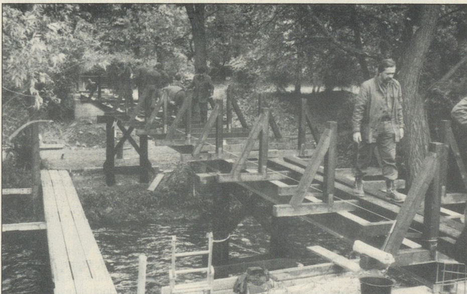
Der Fußgängersteg über den Zwettl bach wurde durch eine Bundesheereinheit errichtet
