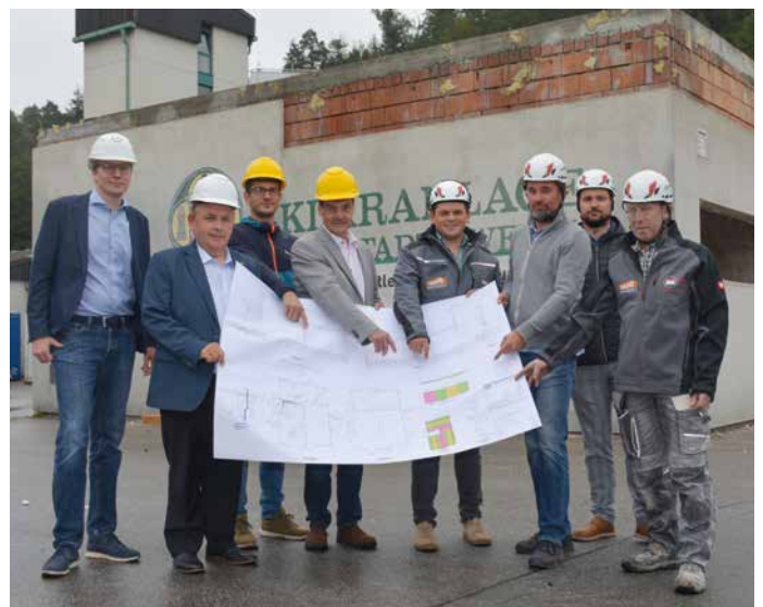
Die Sanierungsarbeiten bei der Kläranlage laufen, die Fertigstellung ist für 2023/24 geplant.
