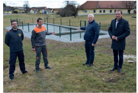
Der Löschbehälter in Oberstrahlbach wurde saniert, im Bild: Kommandant OBI Markus Neunteuf, Thomas Koppensteiner, Ortsvorsteher Anton Waldhäusl und Stadtrat Ing. Gerald Gaishofer.
