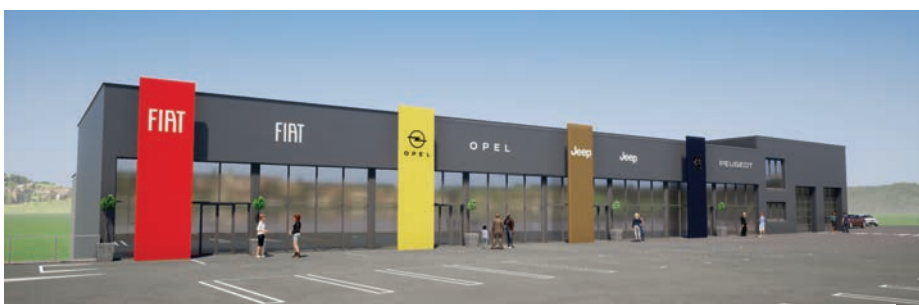
Das Lagerhaus baut ein neues Autohaus, so soll es bei der Eröffnung im Frühjahr 2024 aussehen.
